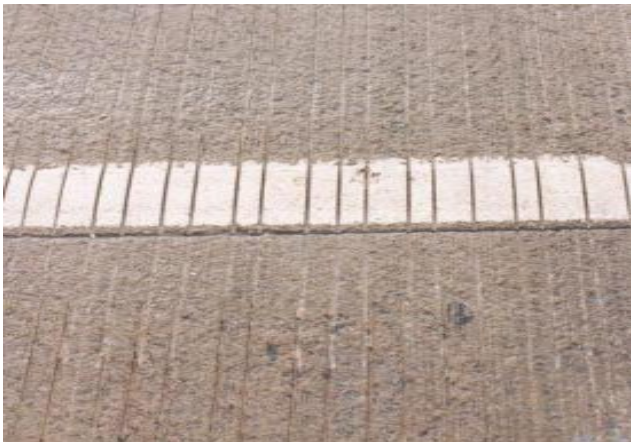
Transverse grooving (concrete)
